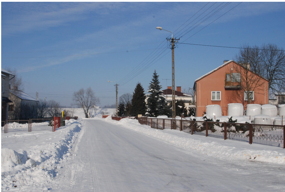
Droga w Średnicy – Maćkowieżach. W tle widoczny nasyp i tory kolejowe.
