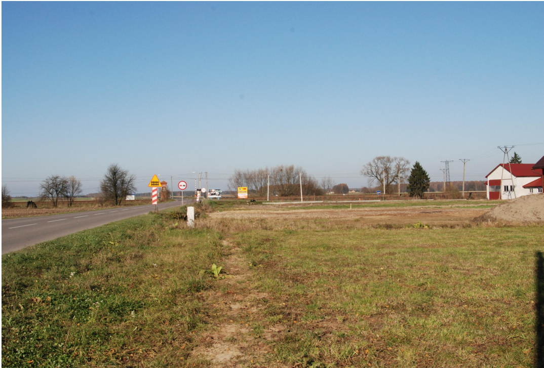
Po lewej – zmodernizowana droga.
