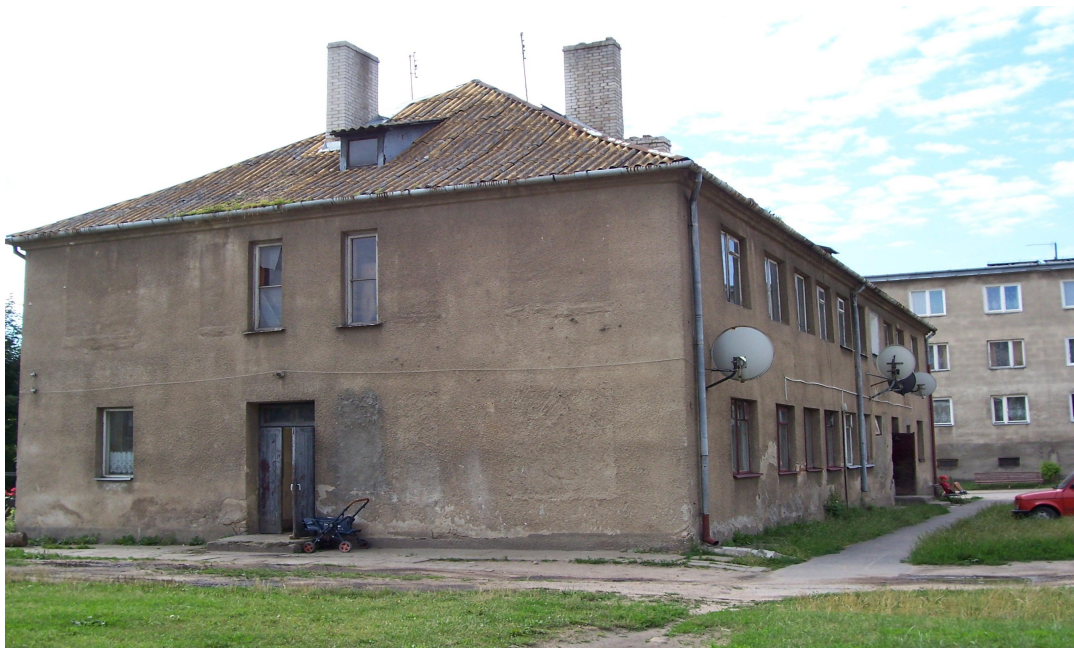
Dawny budynek służby dworskiej.
