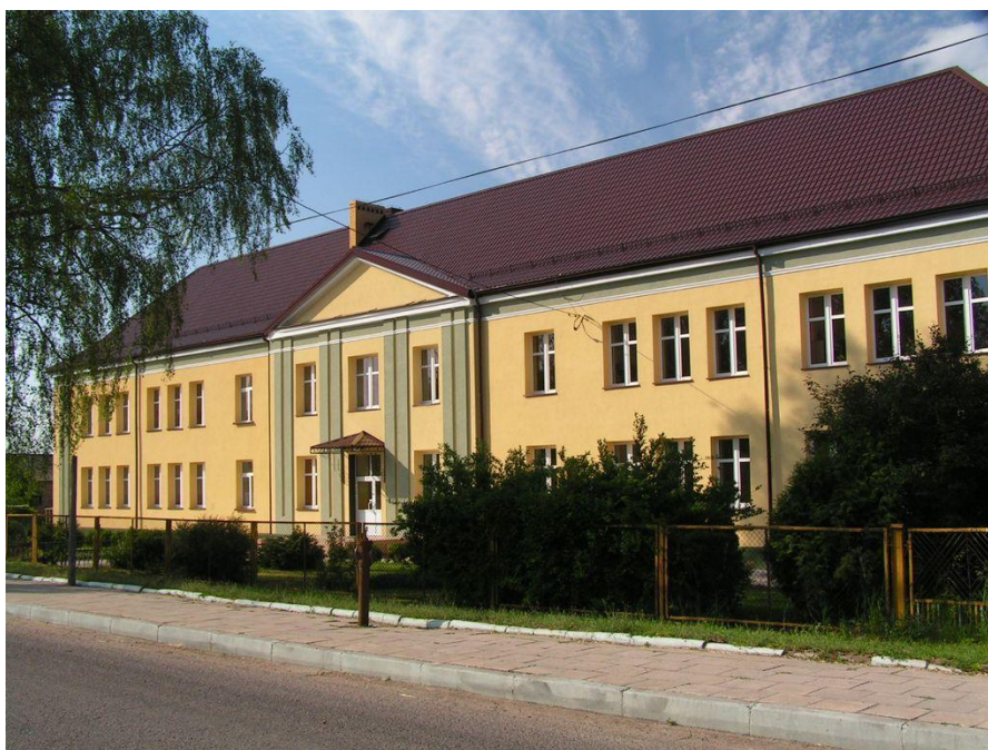
Budynek Szkoły Podstawowej
