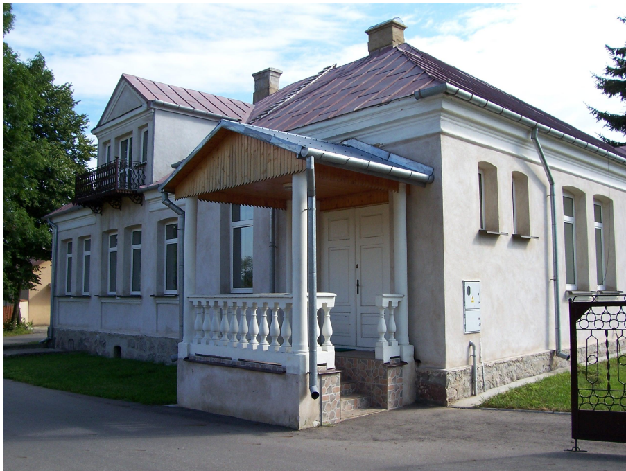
Plebania murowana z lat 1913 – 1924
